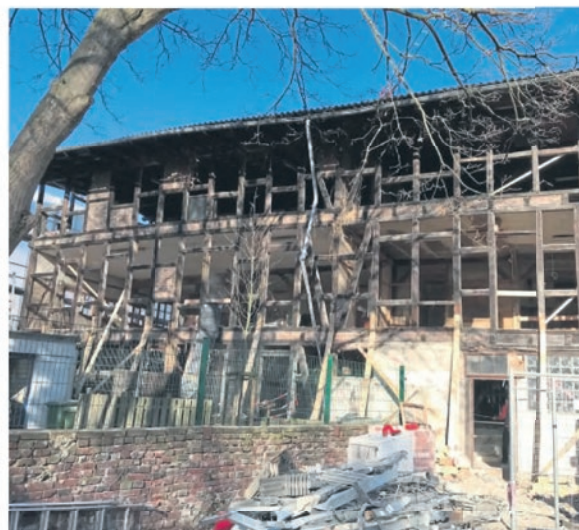
Das sieht nach viel Arbeit aus: Die Rückseite des Anno ist in den letzten Tagen bereits aufgebrochen und entkernt worden. Gut zu erkennen ist die denkmalgeschützte Fachwerkkonstruktion.
