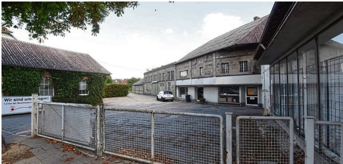
Auf der Brachfläche sollen die Grundlagen für die Errichtung von drei Wohnhäusern geschaffen werden.
