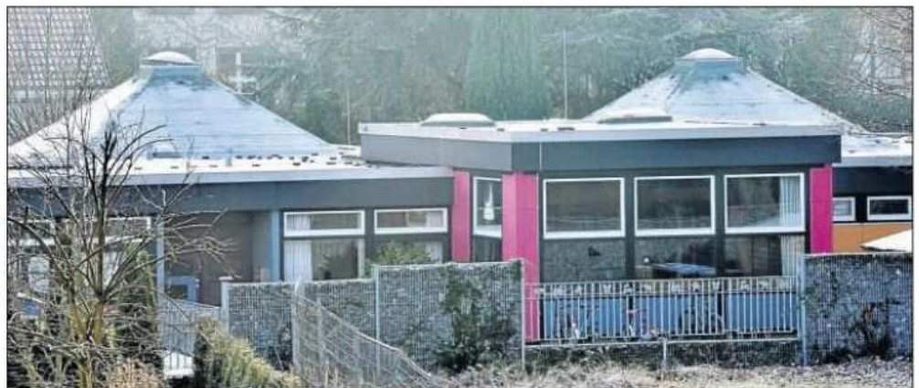
So sieht der Patroklos-Kindergarten heute aus: Weil im Sanitärbereich Asbest entdeckt wurde, wird der Kindergarten im Sommer abgerissen. Jetzt wurden im Gestaltungsbeirat die Neubau-Pläne vorgestellt. • Foto: Dahm
